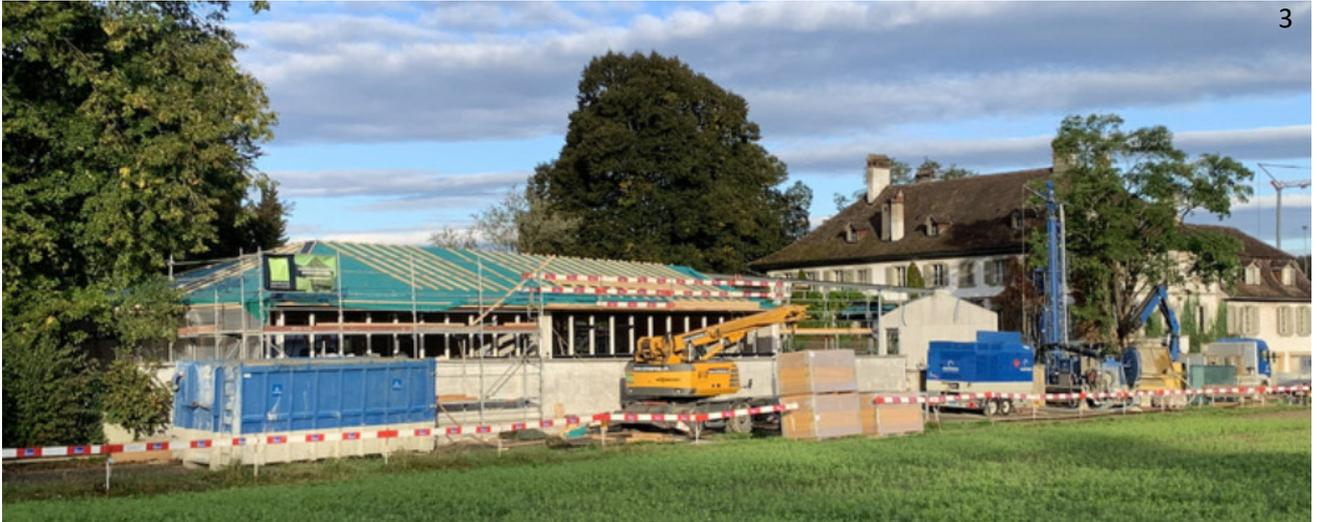
**Image 3:** Perçage des sondes géothermiques lors de la construction du cottage.
