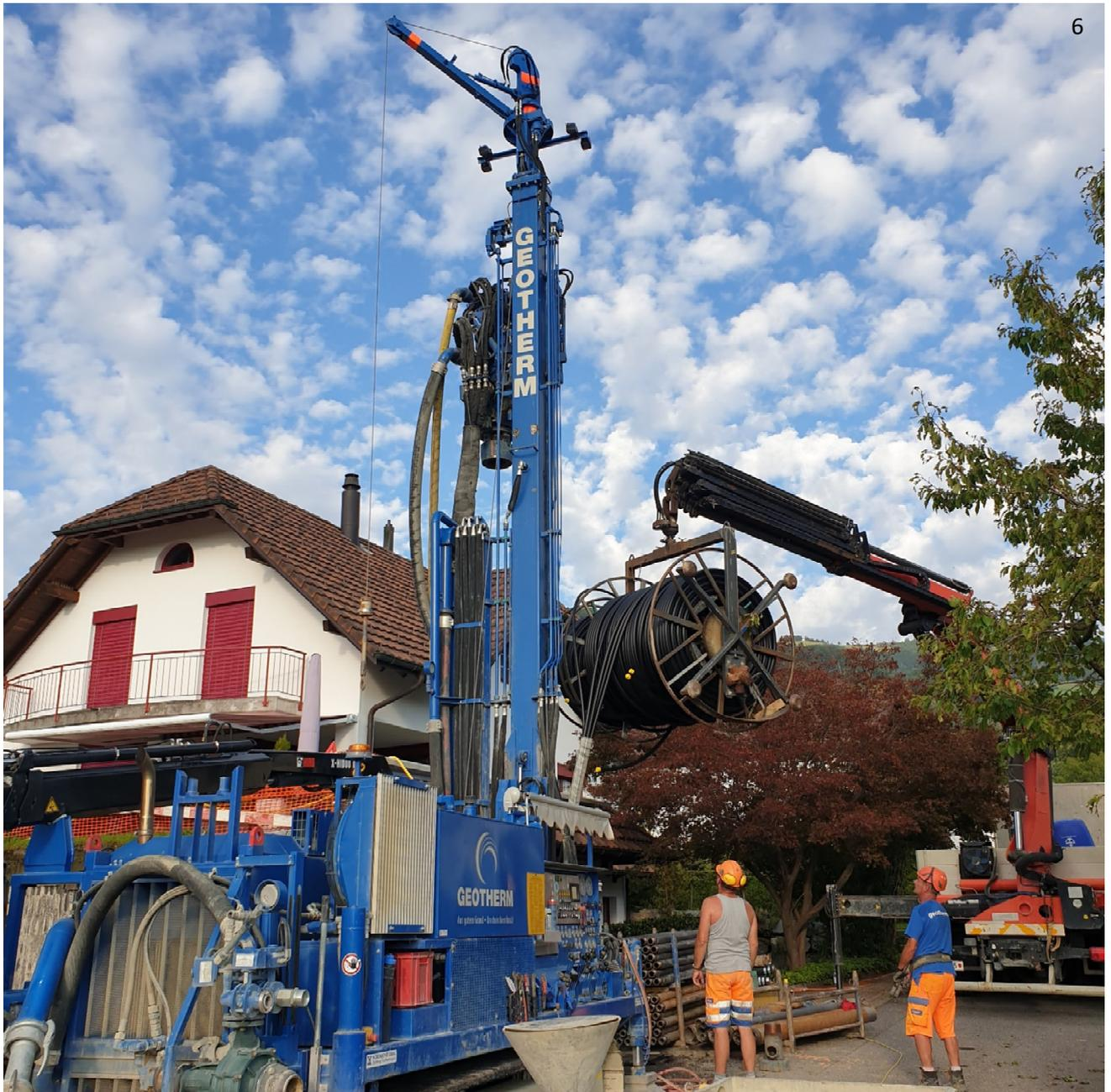
**Bild 6:** Die Erdwärmesonde wird in das Bohrloch abgeteuft.
