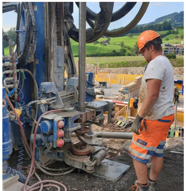
**Bild 2:** Ausbau der Bohrgestänge inkl. Bohrmeissel
