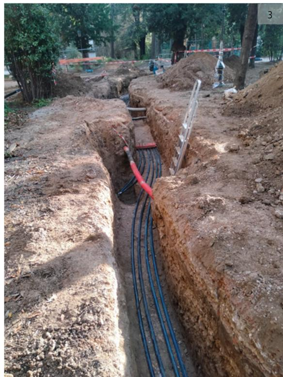
La société Georicerche Srl a également installé les tuyaux de connexion et réalisé les raccordements à six chambres de distribution.
