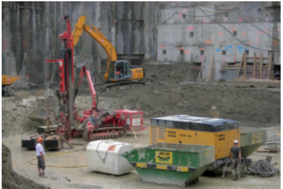
Foreuse en position pour un nouveau forage pour des sondes géothermiques
