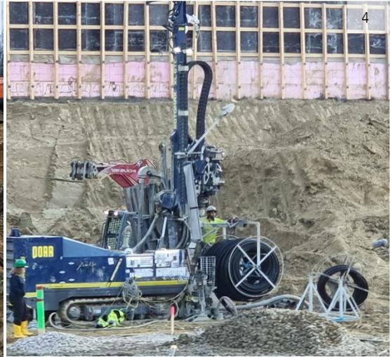
141 sondes géothermiques GEROtherm® DUPL EX d'une longueur de 190 m chacune ont été enfouies sur le champ de forage. En raison de la complexité du sol de la fouille, qui présentait de nombreux niveaux d'excavation différents, les sondes géothermiques ont dû être raccourcies en plusieurs étapes. L'entreprise PORR Bau GmbH, spécialisée dans les forages pour sondes géothermiques, et son
