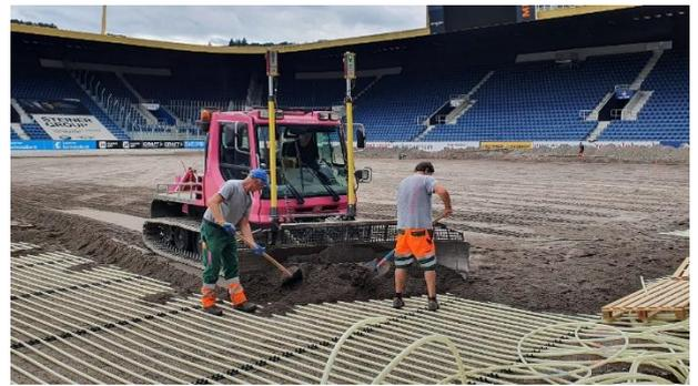
Les anciens tubes dans le sous-sol ont été coupés et une nouvelle couche de mélange quartz-sable de lave a été posée. Le réseau de distribution existant sur toute la longueur du terrain est resté inchangé. Les nouveaux raccords ont été soudés dans le tuyau PE D180 de HakaGerodur existant, qui a été raccordé à l'aide d'un raccord à sertir.
