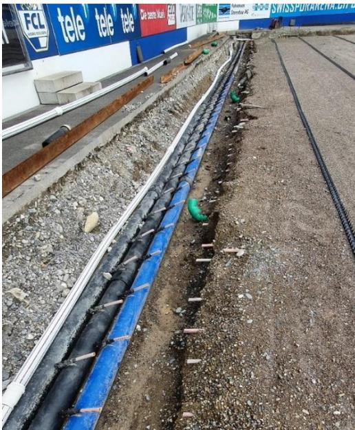
Le nouveau système innovant de raseplan GmbH a été mis en œuvre. La profondeur d'installation réduite des tubes permet un usage plus efficace et plus flexible du chauffage. Les nouveaux tubes ont été raccordés au distributeur PE existant (DE180).
