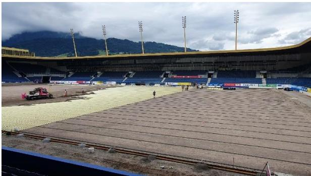
**Image 1:** Les tubes chauffants PE-Xc-O2 sont posés sur un lit de sable
