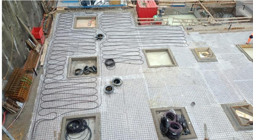
Grâce à son excellente conductivité thermique, plus de 9000 m de notre tuyau GEROtherm<sup>®</sup> de 25 mm en PE100-RC ont été installés. Pour la partie murale, environ 2000 m de tuyaux HAKAthen PE-Xc-O2 de 25 mm ont été posés.
