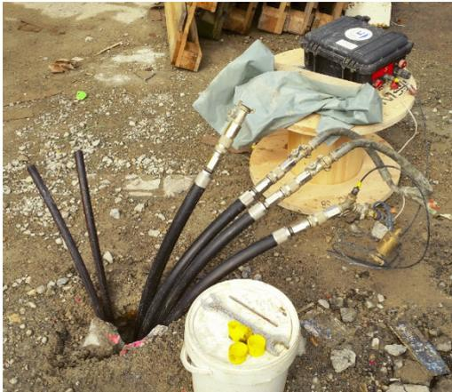
**Image 3:** Sonde géothermique prête pour l'examen de débit et de pression sur le chantier
