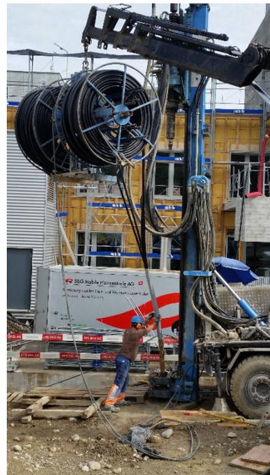
**Image 2:** Montage de la sonde géothermique GEROtherm® VARIO avec et sur la bobine à entraînement hydraulique
