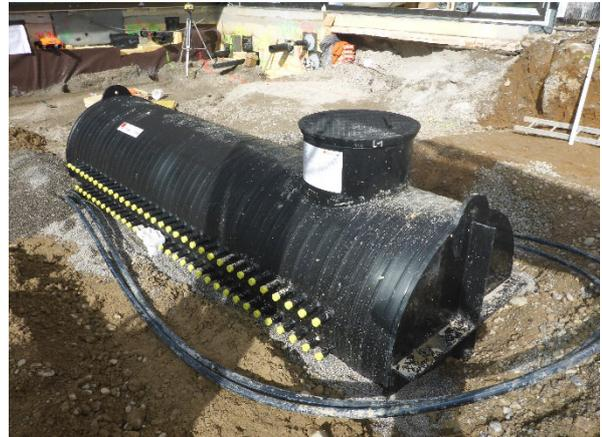
**Image 4:** Chambre en matière synthétique fabriquée sur mesure, robuste et étanche, enterrée à l'extérieur
