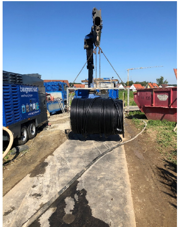
Image 4: GEROtherm® DUPLEX montée sur un dérouleur
