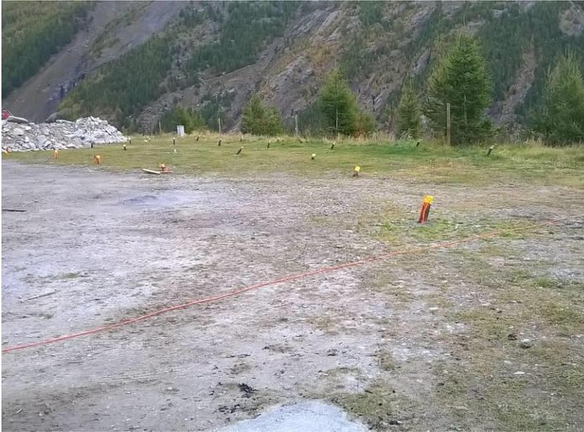
**1** – Erdwärmesondenfeld mit 92 Stk. GEROtherm® Erdwärmesonden 170m
