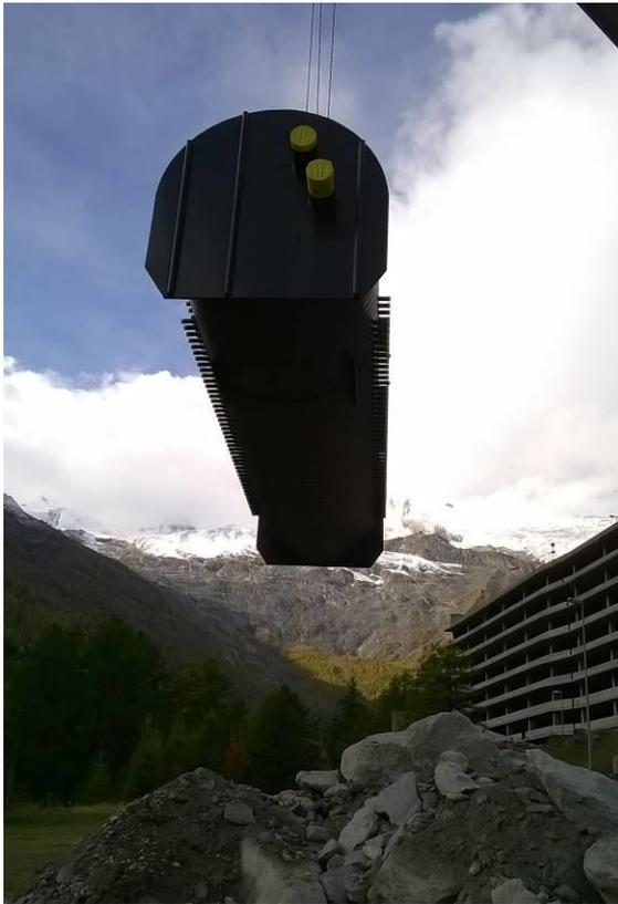
Der schwebende 8.5m lange und 3400 kg schwere Grossverteilerschacht mit 92 Stk. Erdwärmesondenanschlüssen beidseitig de 50 mm.
